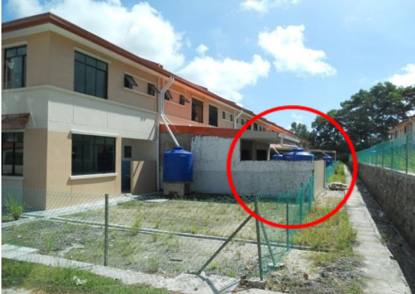
Foto 14 : Tangki Air Hujan Yang Diubah Lokasinya Setelah Kerja Pengubahsuaian Bangunan Dijalankan
