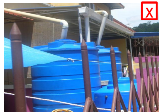
Foto 40 : Contoh Downpipe Yang Kurang Kemas (Taman Mutiara, Sandakan, Sabah)
