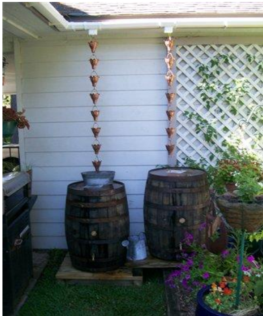
Foto 41 : Rainwater Downpipe Juga Boleh Digantikan Dengan Rantai Air Hujan Yang Menarik
