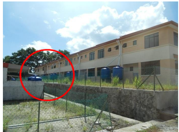
Foto 13 : Pengubahsuaian Rumah yang Masih Mengekalkan SPAH, Tetapi Diubah Lokasi Peletakan Tangki
