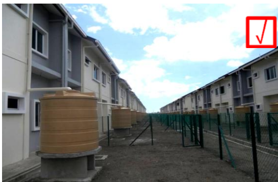
Foto 38 : Contoh Downpipe Yang Teratur (Ken Rimba, Shah Alam)
