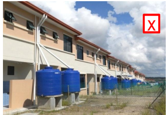
Foto 40 : Contoh Downpipe Yang Kurang Kemas (Taman Mutiara, Sandakan, Sabah)
