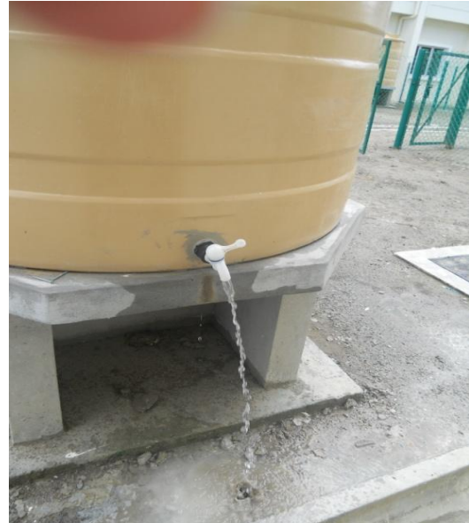
Foto 20 : Ketinggian Platform Tangki Yang Sesuai Untuk Mengambil Air
