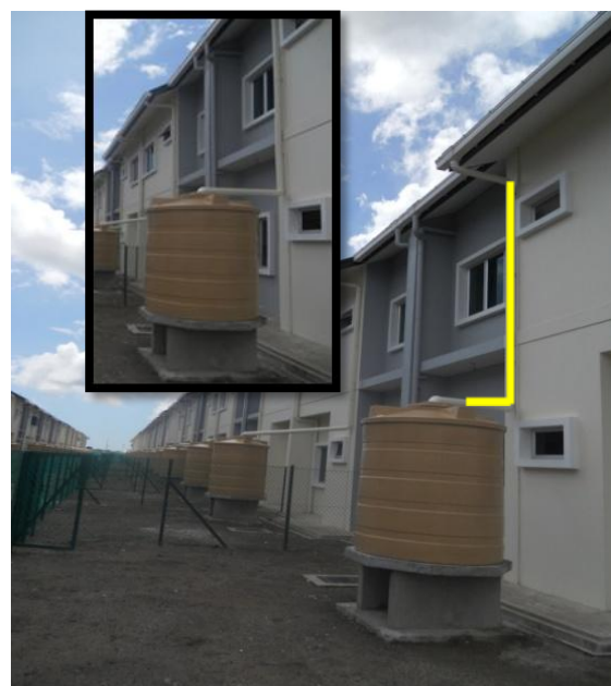
Foto 21 : Downpipe Berbentuk "L"
