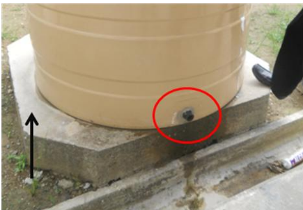
Foto 19 : Kedudukan Tangki Air Yang Rendah Menyukarkan Pengambilan Air
