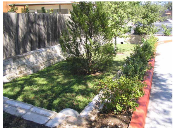
Foto 9 : On-Site Detention Di Plot Kecil
