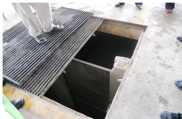
Foto 34 : Kompartmen Bawah Tanah Untuk Mengisi Air Hujan
