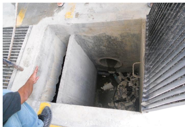
Foto 34 : Kompartmen Bawah Tanah Untuk Mengisi Air Hujan
