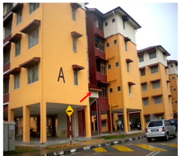
Foto 29 : Kedudukan Tangki Air Hujan Di Setiap Blok
