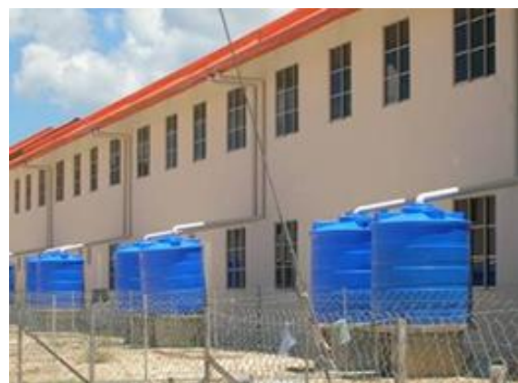
Foto 3 : Contoh Tangki Penyimpanan Air Atas Tanah
