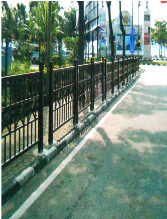
Foto 38 : Rekabentuk laluan pejalan kaki yang mengambilkira ciri-ciri Bandar Selamat dengan penyediaan rel penghadang
