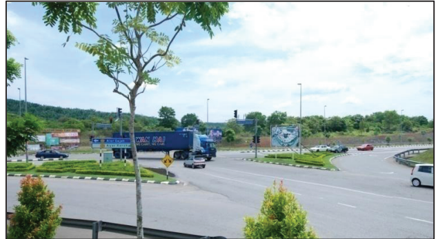
Foto 12: Contoh aksesibiliti yang baik untuk ke kawasan terminal (Terminal Kenderaan Berat Durian Tunggal, Melaka, 4.4.2012)
