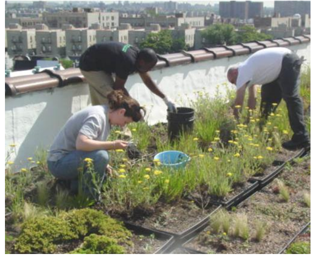
Foto 16: Contoh kerja-kerja penyelenggaraan di taman atas bumbung.
