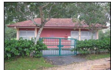
Contoh Pencawang elektrik (PE)
