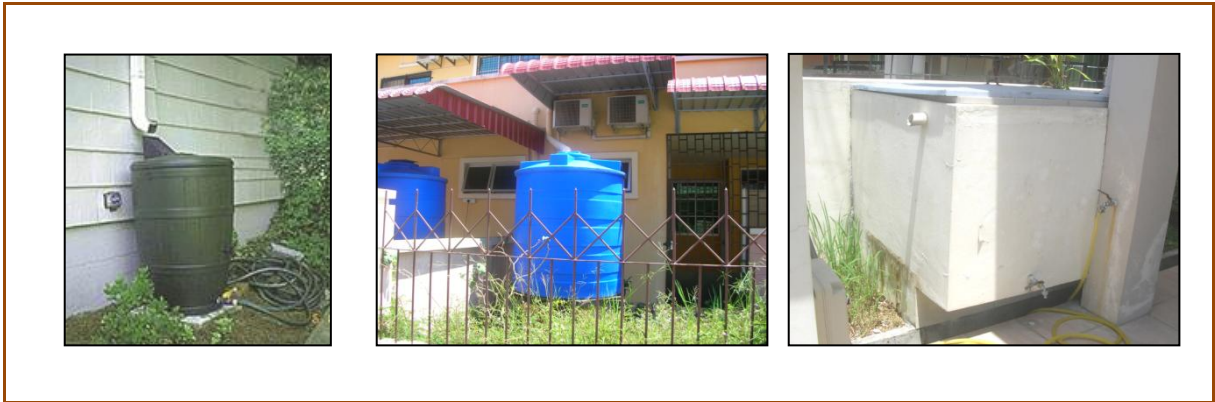
Rajah 7.7: Contoh-Contoh Kaedah dan Peralatan Penuaian Air Hujan Di Premis Kediaman
